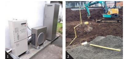
1.給湯器設置状況 2.ガス供給管配管状況
