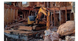
1.木造住宅解体状況
