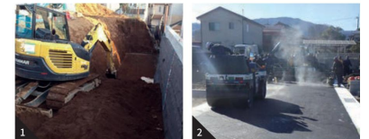
1.擁壁工作後、埋戻状況 2.開発道路の舗装状況
