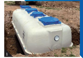
1.宮古島にて浄化槽(40人槽)設置状況
